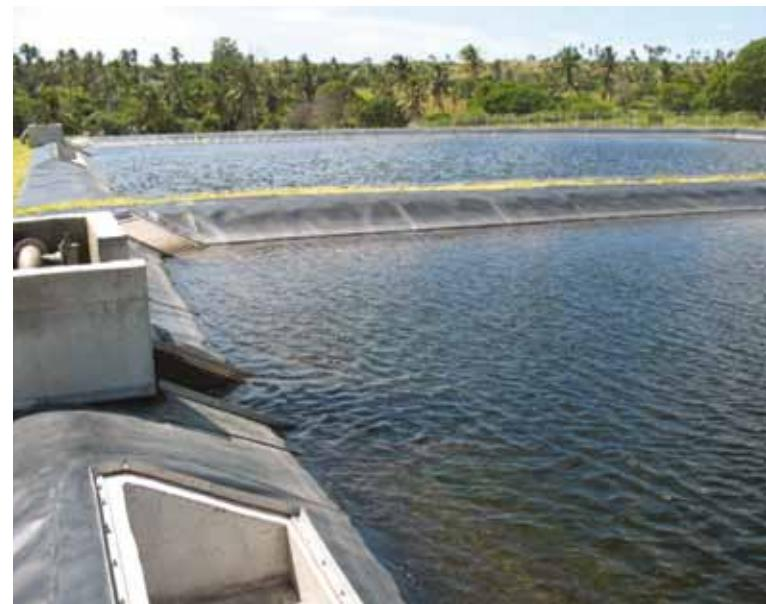
Processo de tratamento, em Inhambane, através de filtração lenta em areia.
