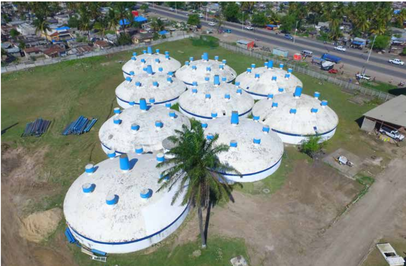
Centro Distribuidor da Munhava (Depositos)
